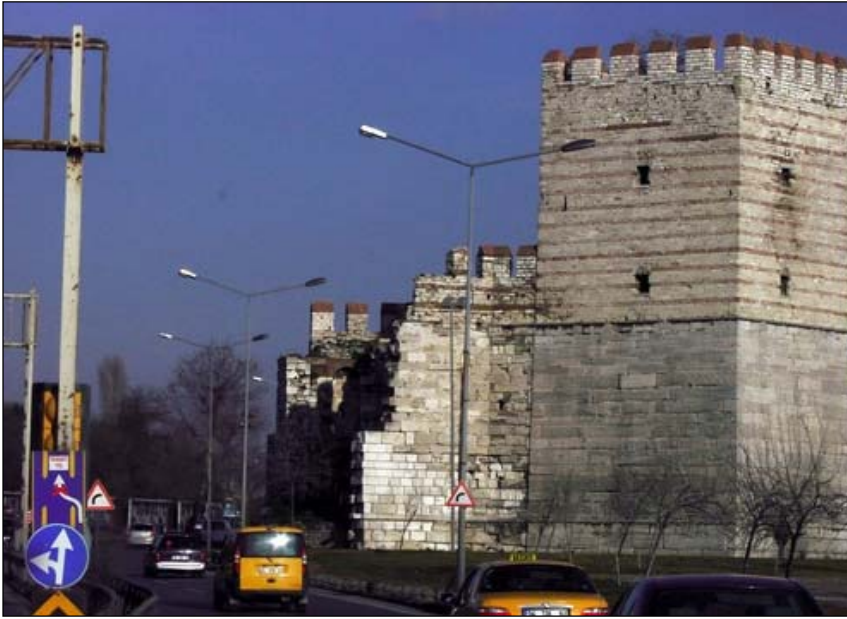
Şekil 1: Mermer Kule yapısının yakınındaki mevcut Kennedy Caddesi
